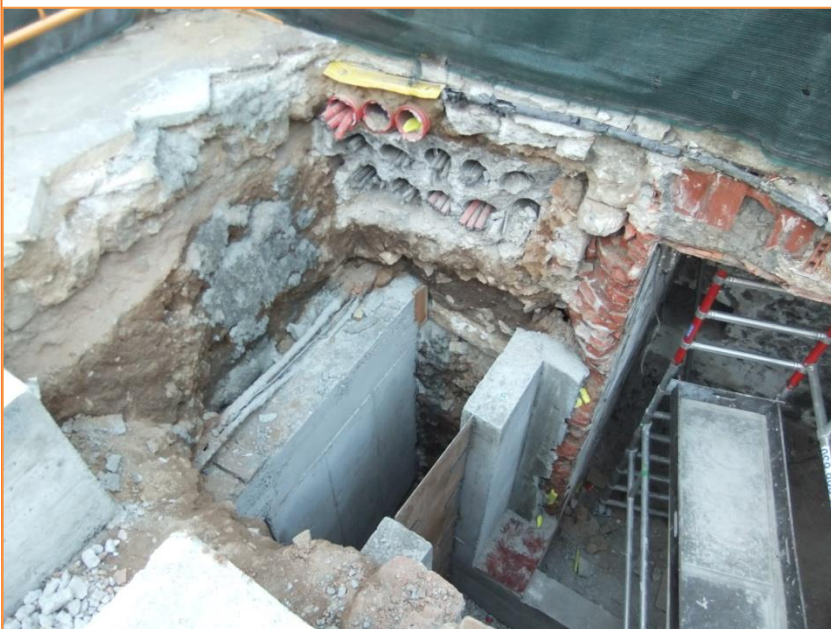
Foto 18. Vista general del seguiment de construcció de les pantalles.
