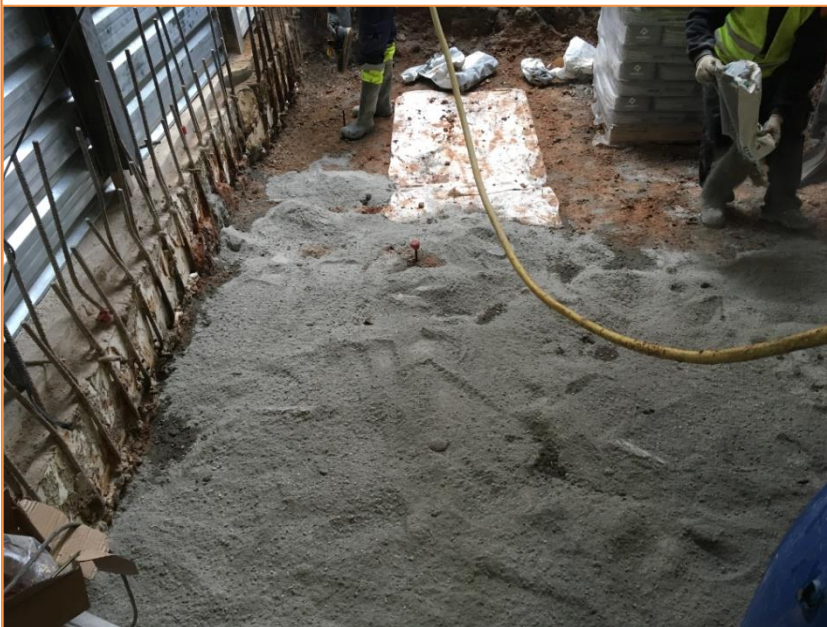
Foto 70. Vista del cobriment del pou UE 300 amb una llosa de formigó.
