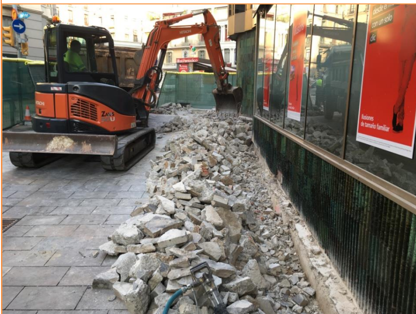
Foto 6. Vista de l'inici dels treballs a la rasa de serveis.
