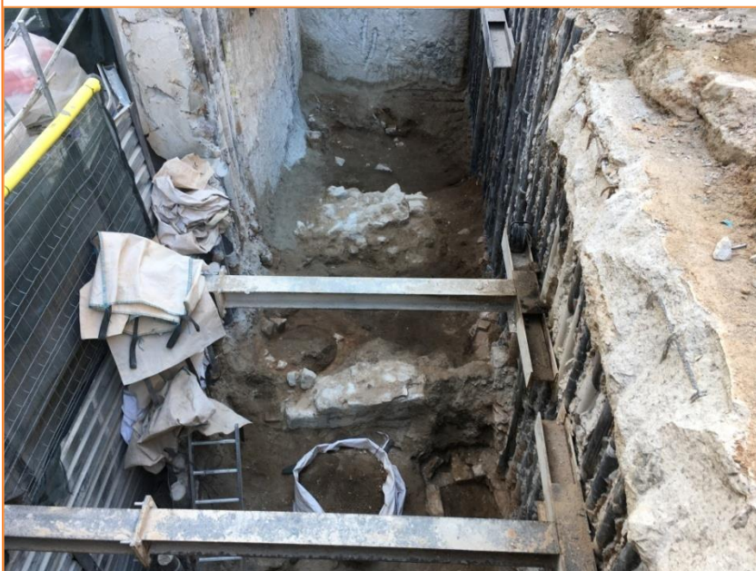
Foto 72. Vista de l'estat inicial a la zona de les antigues escales.
