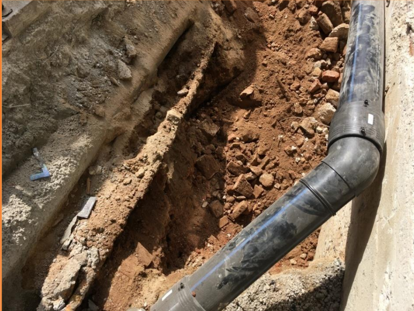
Foto 7. Vista de la UE 2 a la rasa de serveis.
