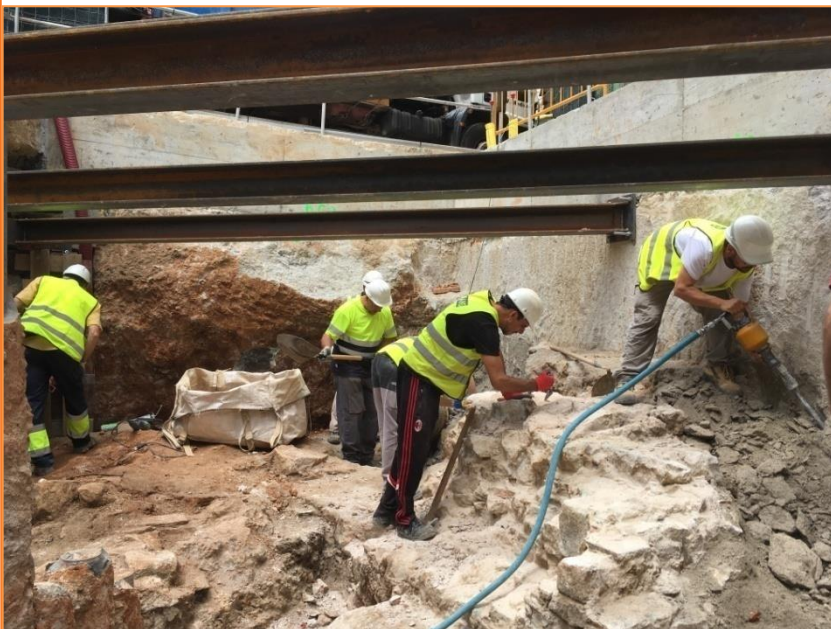
Foto 33. Vista dels treballs de desmuntatge dels murs UE 105 i UE 115.
