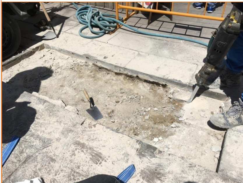
Foto 1. Vista de l'inici dels treballs a la cala núm. 1.
