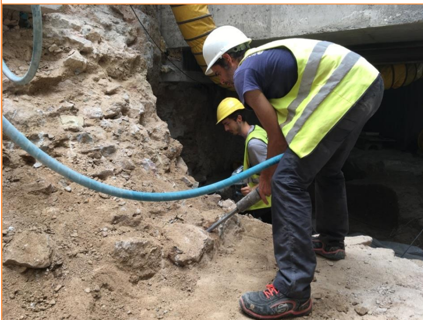
Foto 40. Vista dels treballs de desmuntatge del mur UE 36 sota llosa.
