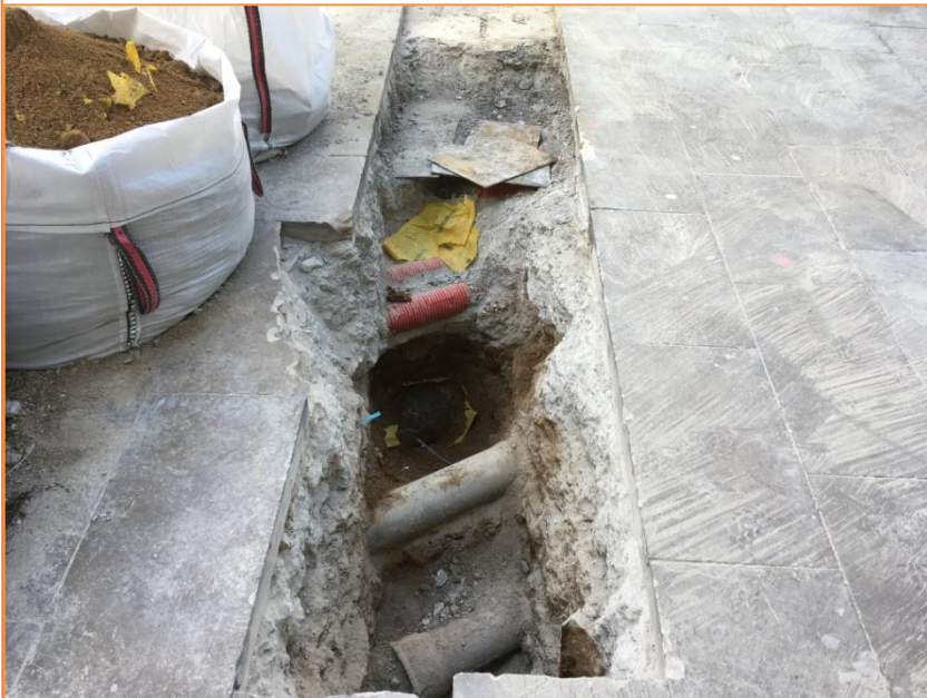
Foto 5. Vista dels serveis a la cala núm. 3.
