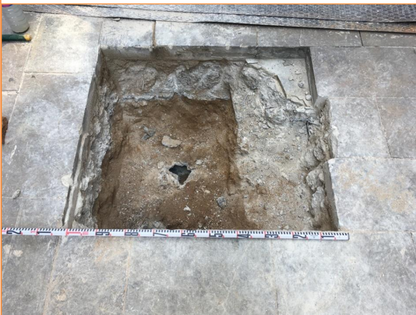
Foto 10. Vista de l'ampliació de la cala núm. 4.
