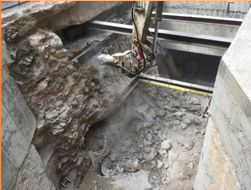
Foto 43. Vista dels treballs de repicar l'hastial de formigó.
