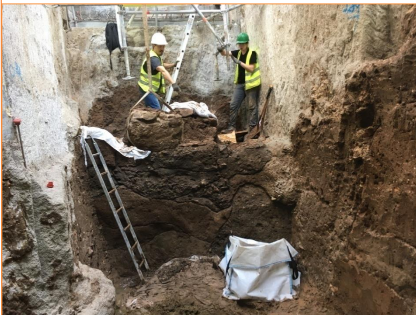
Foto 58. Vista dels treballs de desmuntatge del pilar UE 226.
