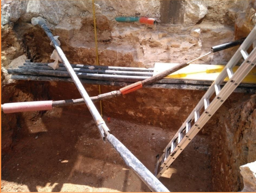
Foto 11. Vista del mur UE 8 al 1r prisma de telefonia.
