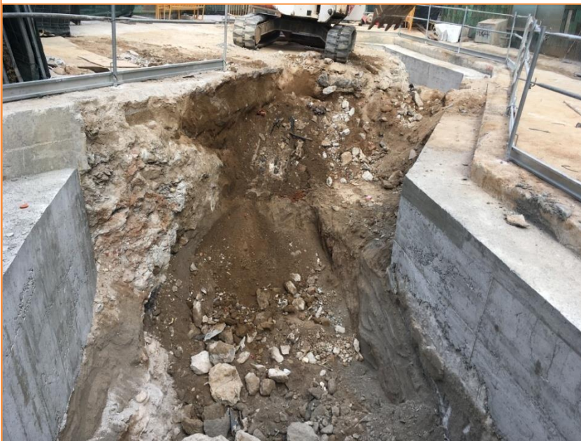
Foto 28. Vista dels treballs d'extracció de terres a l'estació d'Argenteria.
