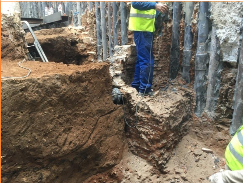
Foto 81. Vista dels treballs de desmuntatge del dipòsit UE 310.
