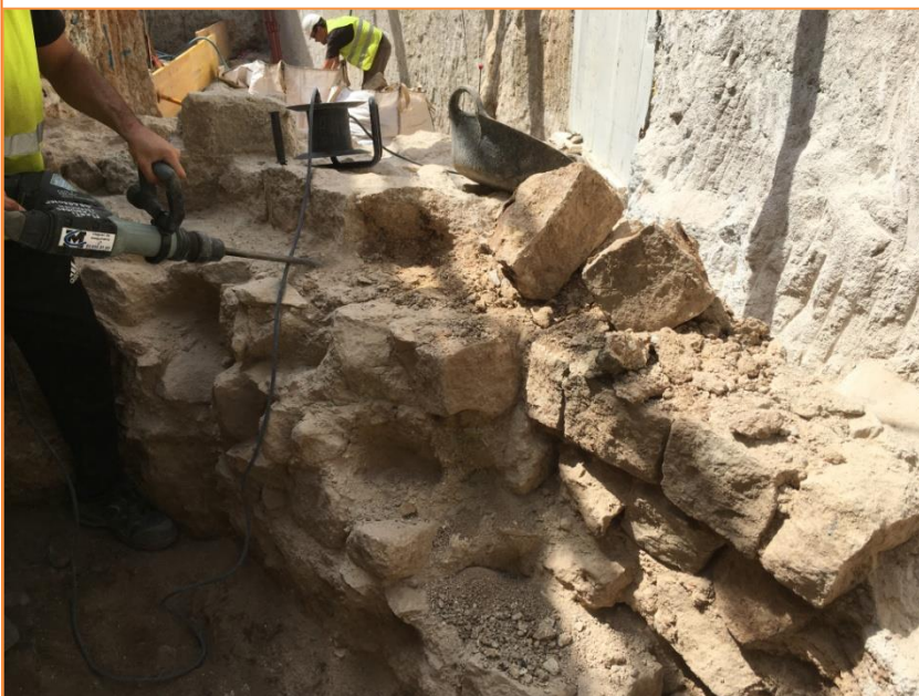
Foto 34. Vista dels treballs de desmuntatge del mur UE 36.
