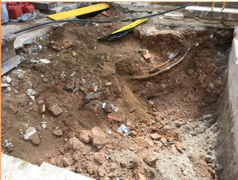
Foto 44. Vista dels treballs d'obertura de les escales d'accés.
