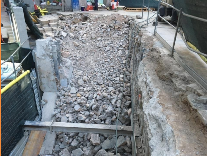
Foto 65. Vista de l'inici del desmuntatge de les antigues escales de l'estació.
